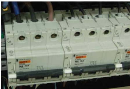
Disjoncteurs C60L Ma à raccorder en aval du disjoncteur général
