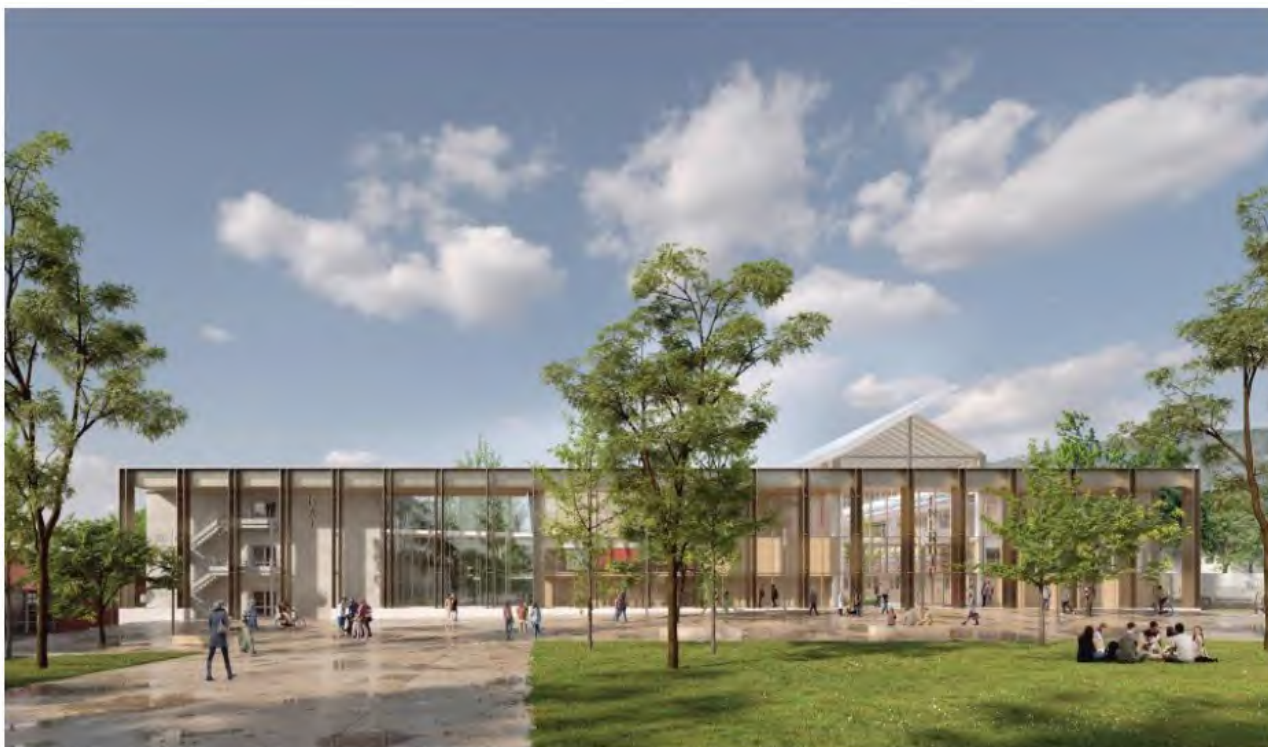
Le bâtiment Énergie, vitrine du projet Ecocampus NFC
