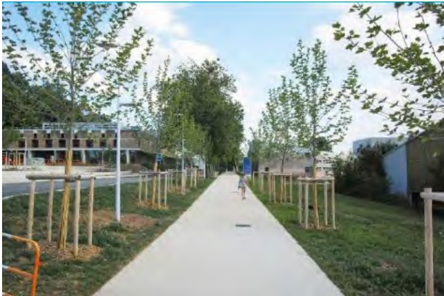
Réhabilitation et végétalisation de la place centrale
