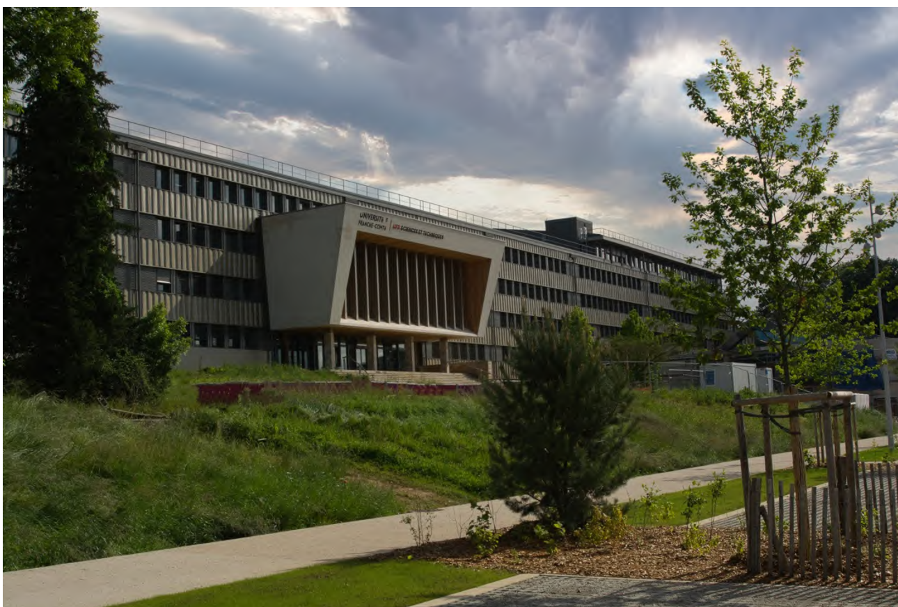
Le bâtiment Métrologie B réhabilité (le bâtiment A est encore en travaux)
